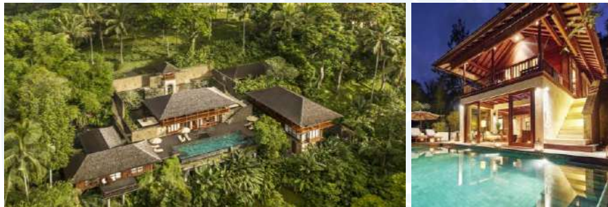
Gambar 3. 1, Desain Eksterior Como Shambhala Estate Sumber : https://www.comohotels.com/en/comoshambhalaestate
