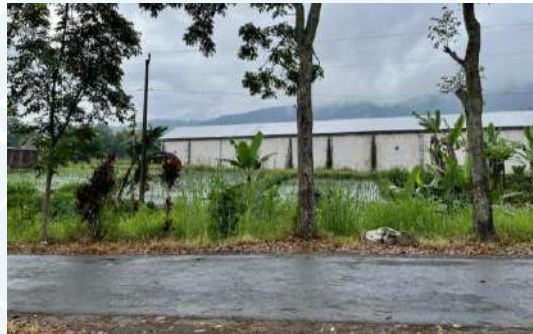
Gambar 3. 7, Kondisi Jalan Sumber : Dokumentasi Penulis, 2022
