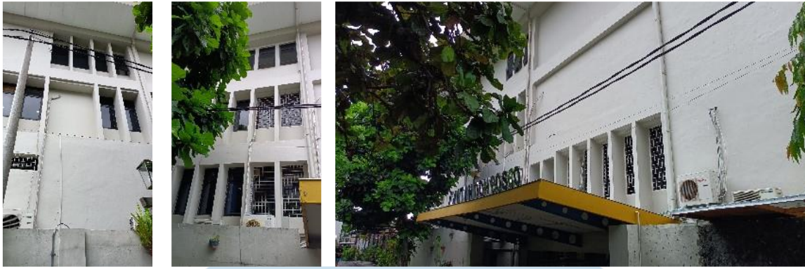
Gambar 4 Jendela Sisi Utara Bangunan
