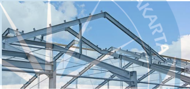
Gambar 6.12. Rangka Atap baja
