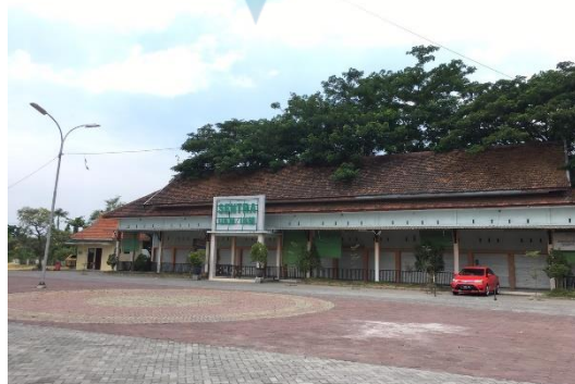
Gambar 1.4: Kios-kios UMKM Sumber: dokumentasi penulis
