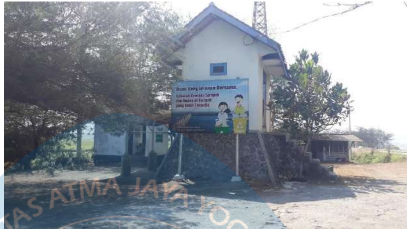
Gambar 3.27 Ruang Panel Listrik Sumber : Dokumentasi Penulis tahun 2019
