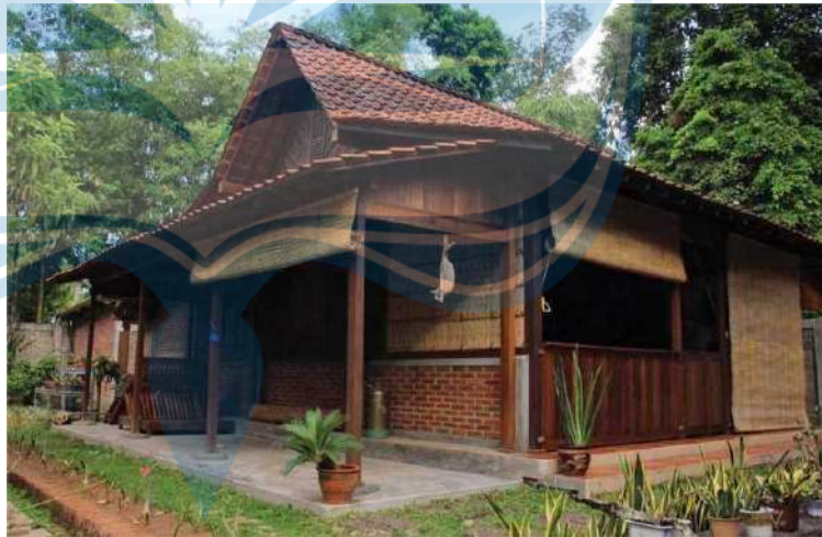
Gambar 3.5 Atap Kampung Sumber : Google Image – 2020
