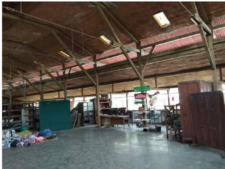
Gambar 2. 6 Salah Satu Fasilitas Bengkel Kerja Sumber : Dokumentasi Lapas Kelas IIA Yogyakarta, 2019
