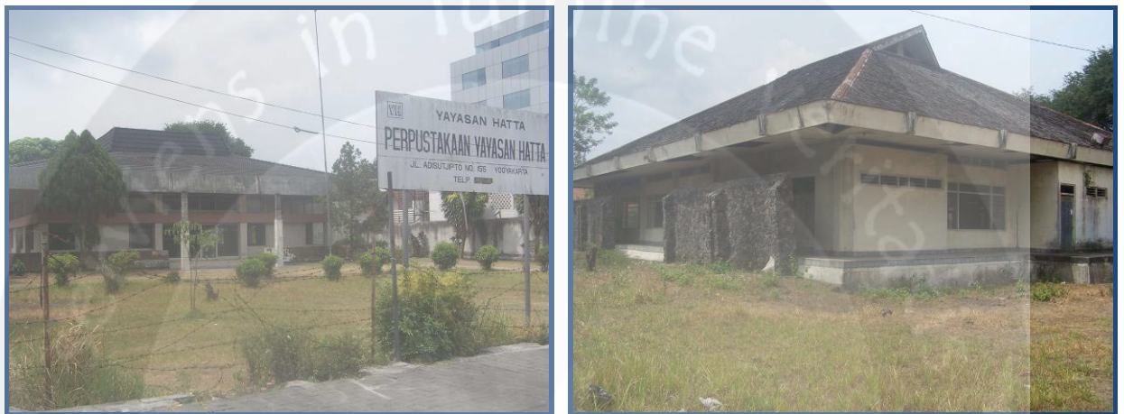
Gambar 1.1: Gedung Perpustakaan umum Yayasan Hatta yang sudah tidak beroperasi dan terbengkalai.
