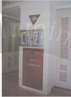
Gambar 2.25 Hidran dan tabung pemadam pada Mall Mangga Dua
