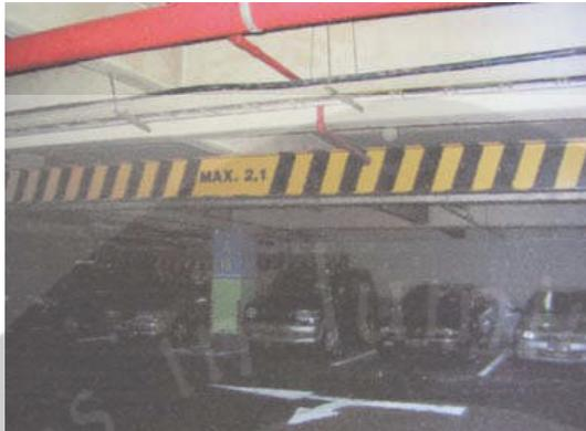
Gambar 2.22 Batas ketinggian mobil pada lantai basement Mall Mangga Dua
