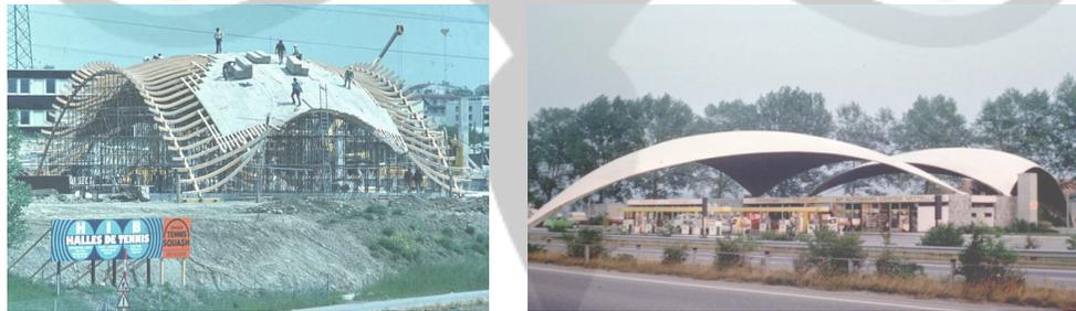
Gambar 5.12 : contoh material struktur cangkang
