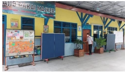
Gambar 2.2 bangunan tambahan pada SDN Ngupasan yang tidak memerhatikan gaya arsitektur Indis Transisi
