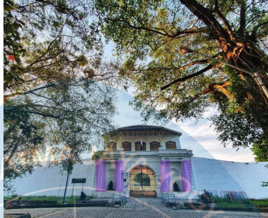
Gambar 2.2 Kolom Tuscan pada Fasad Benteng Vastenburg
