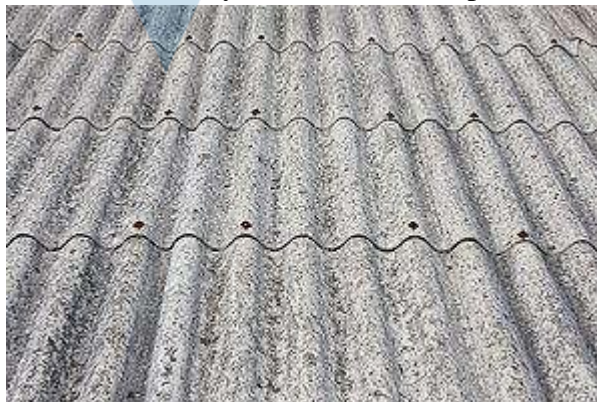
Gambar 2.11 Gambaran atap asbes
