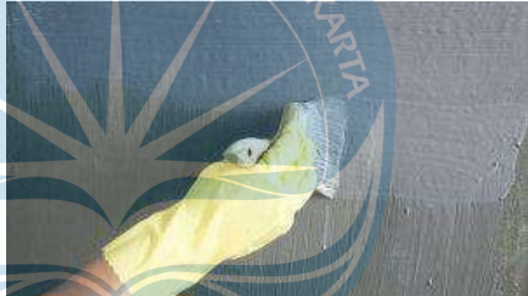
Gambar 2.15 Gambaran lantai kedap air campuran plester
