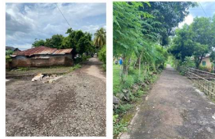
TIDAK ADANYA UTILITAS PENERANGAN PADA KAWASAN.
