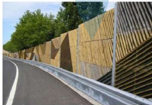
Gambar 3. Berier pada sisi jalan raya
