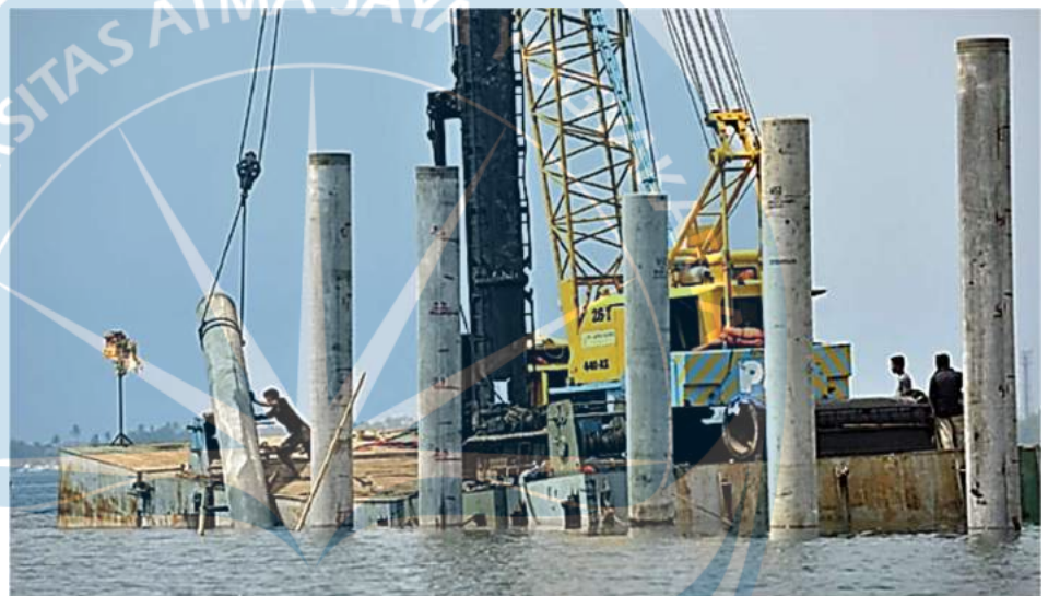
Gambar 6.15 Fondasi Tiang Pancang
