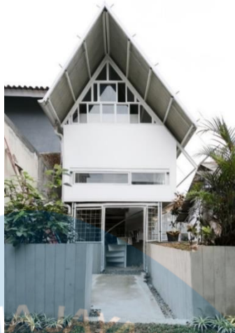
Gambar 2.22 Tampak depan Arsyah House
