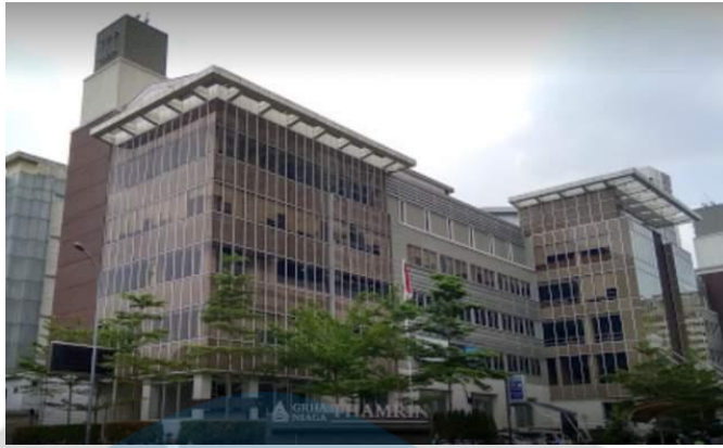
Gambar 2. 10 Gedung JCH Sumber : Lamudi.co.id
