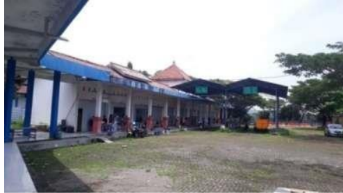
Gambar 1.3 : Terminal Angkutan Desa
