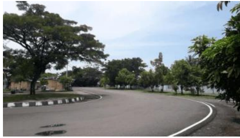
Gambar 2.16 : Jalan Sirkulasi Bus di Dalam Terminal Bus Kebumen
