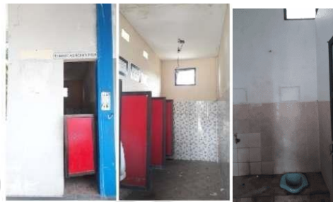
Gambar 2.27: Toilet Umum Pria (kiri) dan Toilet Umum Wanita (kanan)
