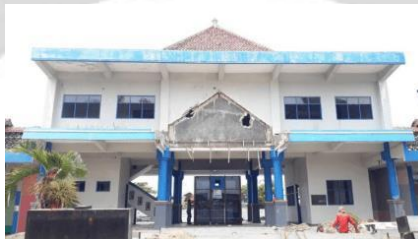
Gambar 2.23: Bangunan Kantor Terminal
