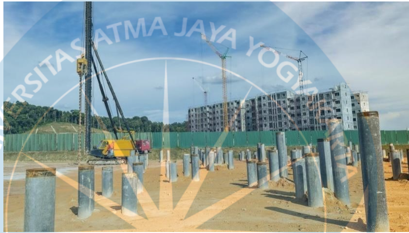
Gambar 6.6 Pondasi tiang pancang Sumber: google.com , 2020
