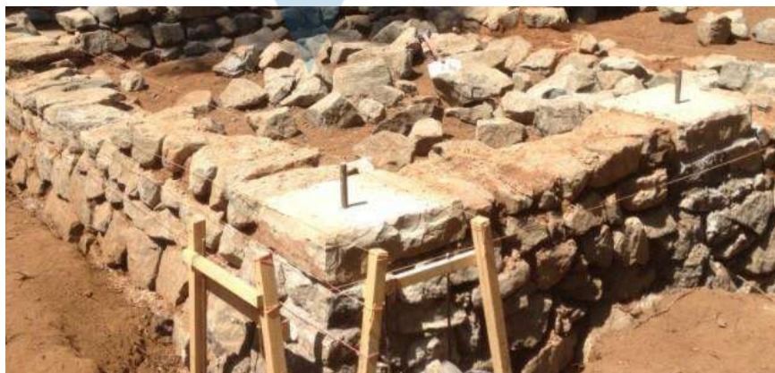
Gambar 6. 13 Fondasi Batu Kali (Sumber: https://renovasi.co.id/pondasi-batu-kali/ )
