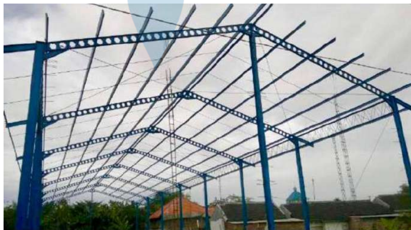
Gambar 6. 15 Konstruksi Baja (Sumber: https://bengkellastrikajaya.com/project/konstruksi-baja-wf-h-beam/ )
