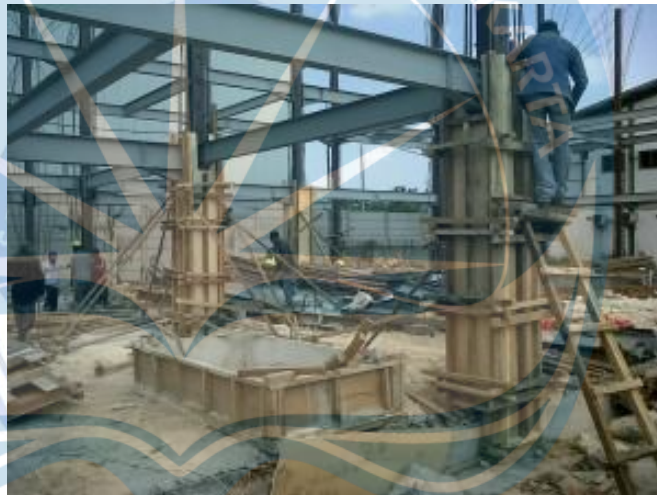
Gambar 6.7 Proses Pendirian Kolom Komposit
