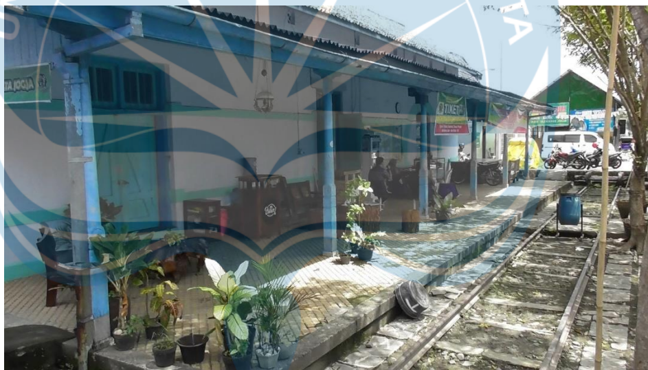
Gambar 1.3 Jalur kereta yang sudah tidak terpakai
