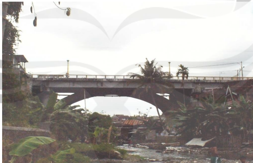
Gambar 1.4 Jembatan Gondolayu Yogyakarta
