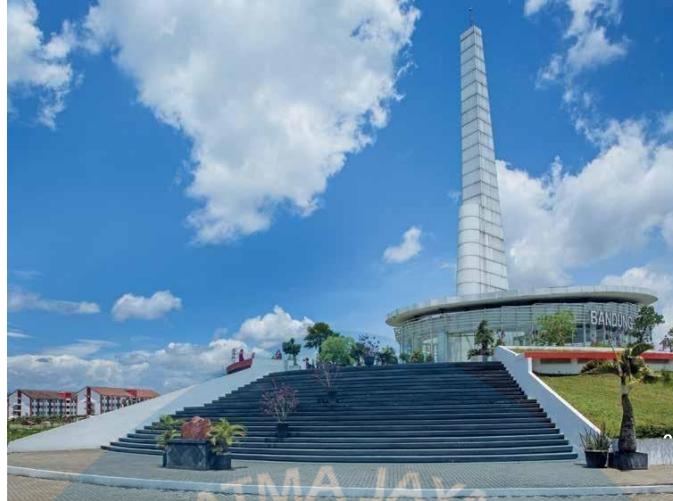
Gambar 2. 18 Trap Tangga pada area entrance gedung BTP
