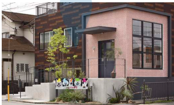
gambar 2. 30 Wajah depan bangunan
