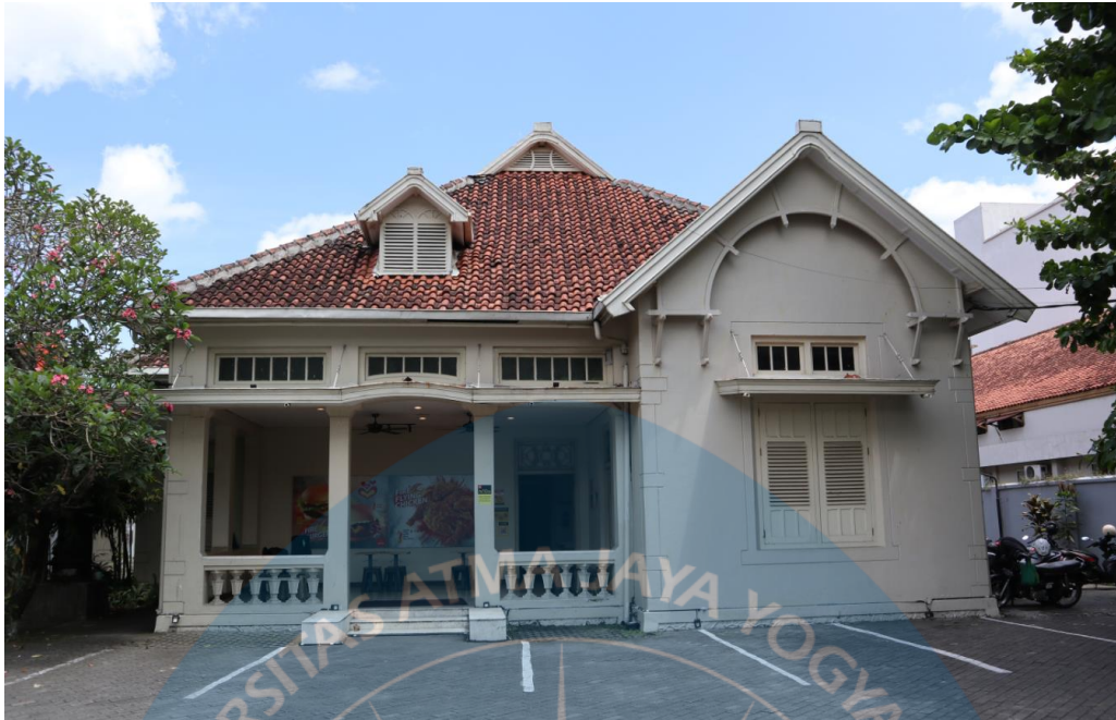
Gambar 1. 5. Bangunan Richeese Factory Yogyakarta Jl. Jend. Sudirman No.46, Kotabaru, Kec. Gondokusuman, Kota Yogyakarta, Daerah Istimewa Yogyakarta 55224 Sumber foto: Pinthoko Nugroho (April-2023)
