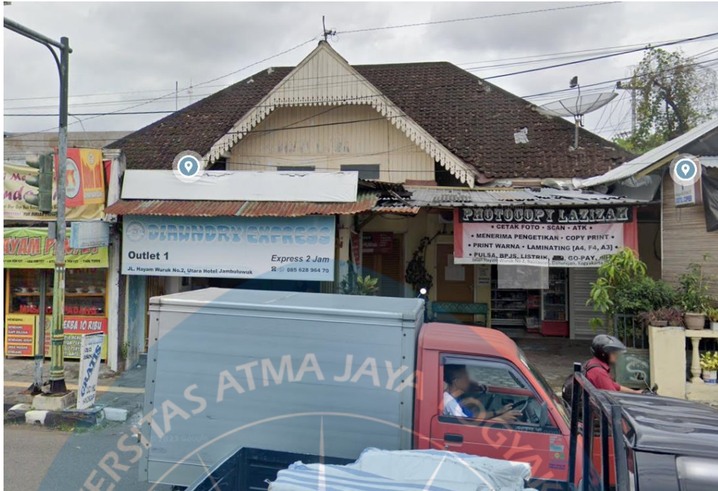
Gambar 1. 9. Bangunan rumah, Jalan Hayam Wuruk No 2, DIY 693F+83 Bausasran, Yogyakarta City, Special Region of Yogyakarta Sumber: google maps
