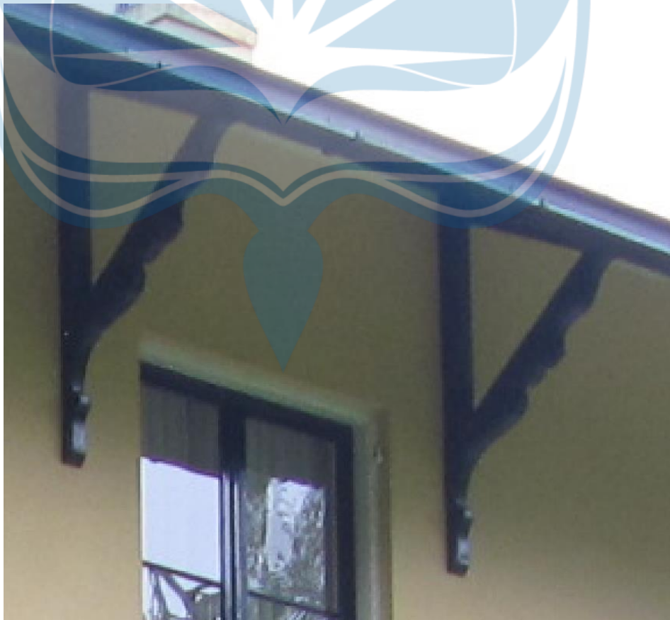
Gambar 2. 24. Detail Konsol kayu pada bangunan Villa Dordwijk Sumber gambar: https://rijksmonumenten.nl/monument/497172/landgoed-dordwijk-gelijknamige-villa/dordrecht/#&gid=1&pid=1
