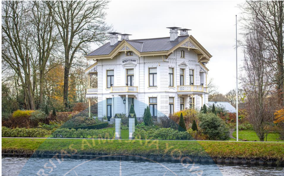
Gambar 2. 25. Bangunan Bosch en Vaart https://afbeelding.dvhn.nl/dvhn/incoming/cy18fp-202012012616.jpg/alternates/LANDSCAPE_960/202012012616.jpg
