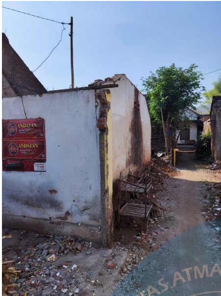
Objek Pengadaan Tanah (Pembongkaran Rumah)
