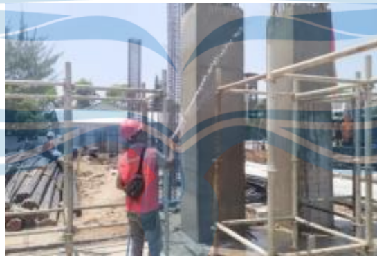
Gambar 2. 38 Curing pada Hasil Pengecoran Kolom
