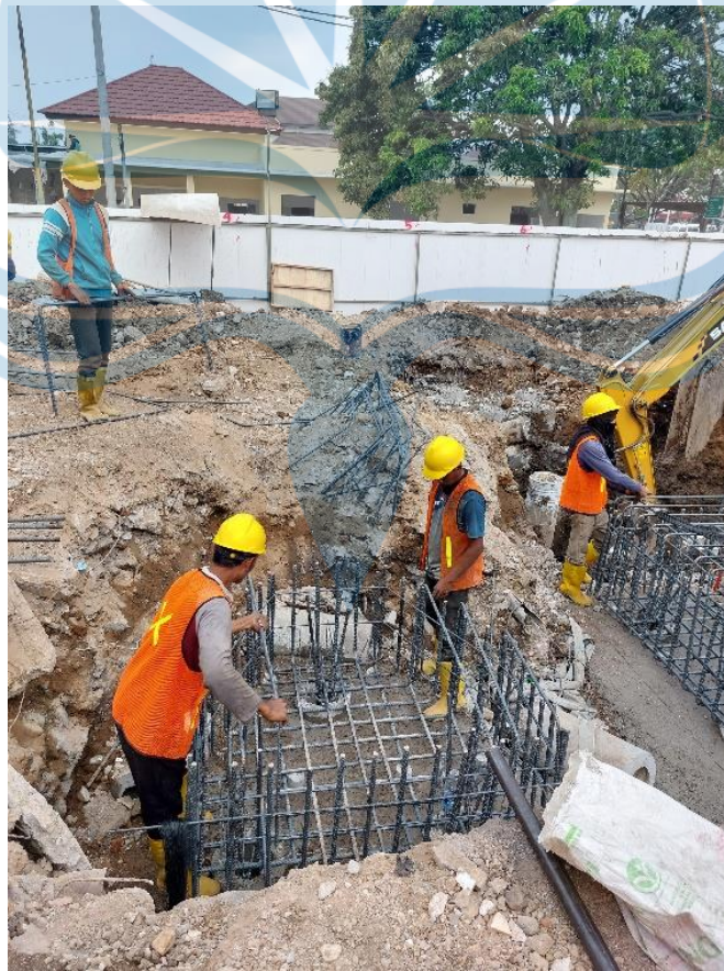
Gambar 2. 8 Pekerjaan Pembesian Pilecap
