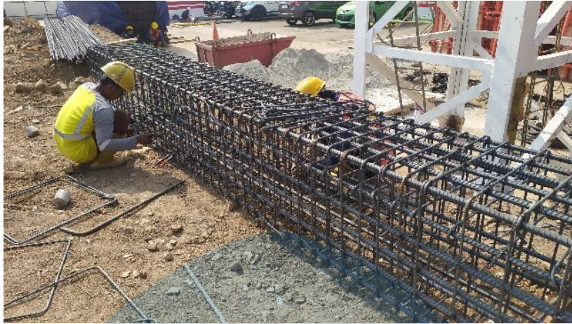
Gambar 2. 9 Pekerjaan Pembesian Kolom
