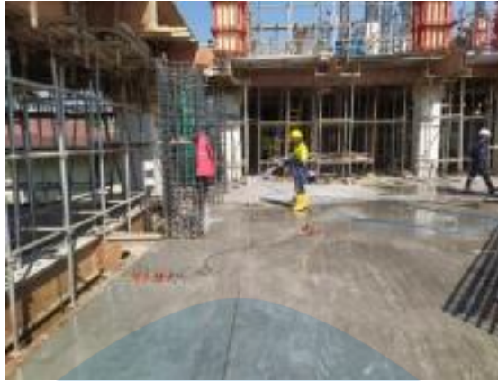
Gambar 2. 39 Curing pada Balok dan Plat Lantai
