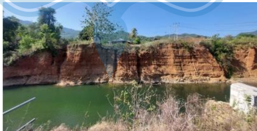
Gambar 2. 3 Kondisi Oprit Bagian Selatan (2023)
