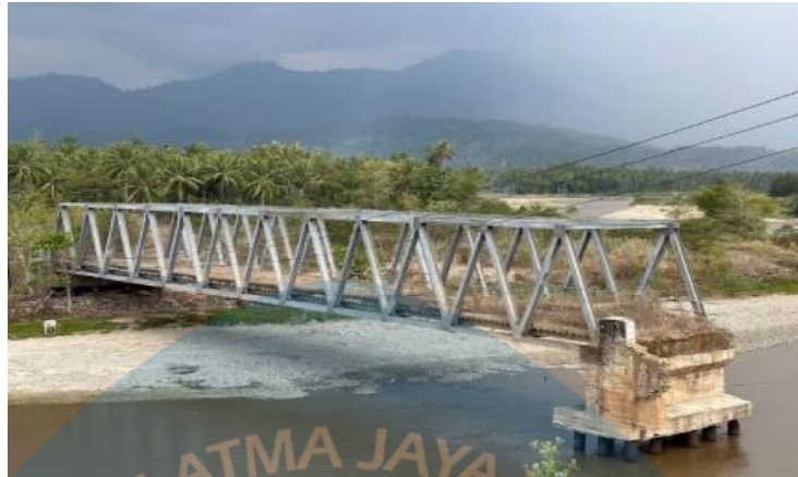
Gambar 2. 2 Jembatan Bulu Bulundu Eksisting (2023)
