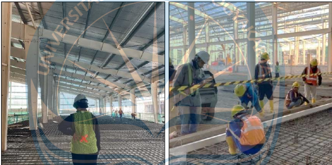
Gambar 2.21 Cek Kualitas Pengerjaan Slab F5
