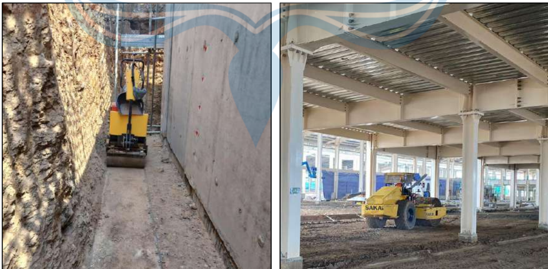
Gambar 2. 20 Proses Pemadatan Tanah pada F5 - PED LAB and GA Engineering Menggunakan Handy Stemper (Kiri) dan Vibro Roller (Kanan)
