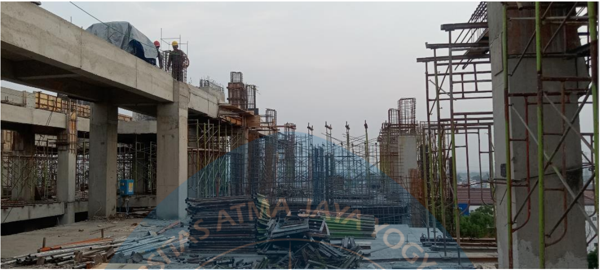
Gambar 5.2 Dokumentasi Pekerjaan Lantai 4
