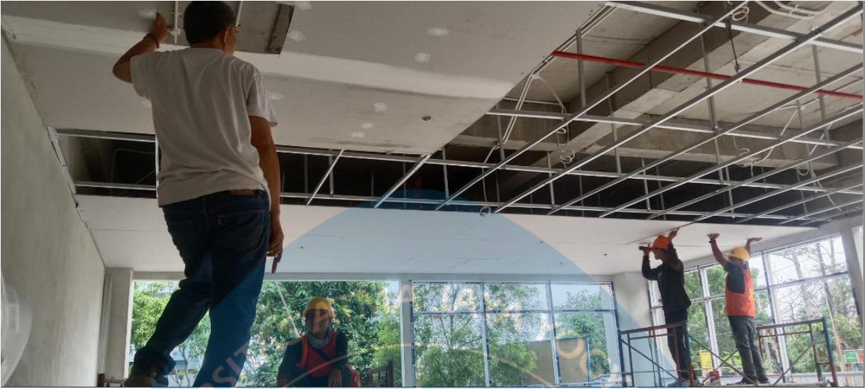
Gambar 5.2 Dokumentasi Pekerjaan MEP
