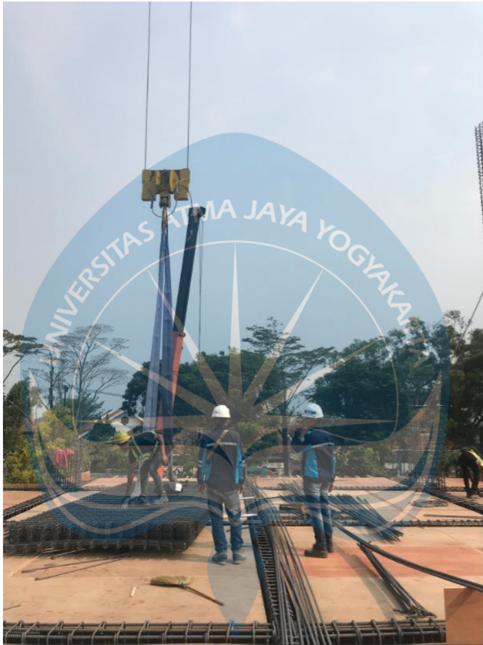
Gambar 5.5 Dokumentasi Pekerjaan Plat Lantai
