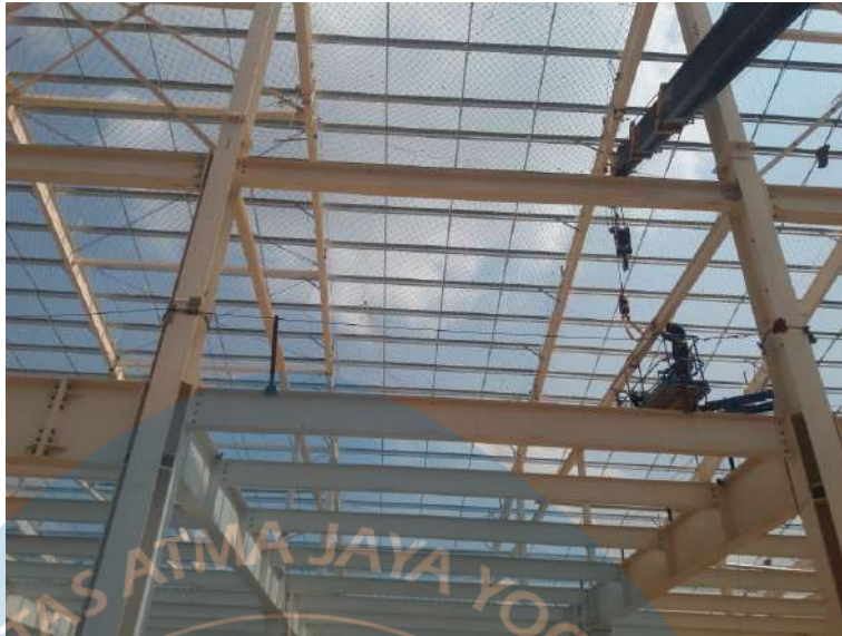
Gambar II. 20 Pengawasan Instalasi Purlin
