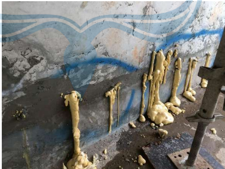
Gambar II. 21 Hasil Injeksi PU pada Dinding
