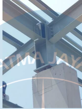
Gambar 2.7 Sambungan Atap pada Proyek Eastvara, Tangerang
