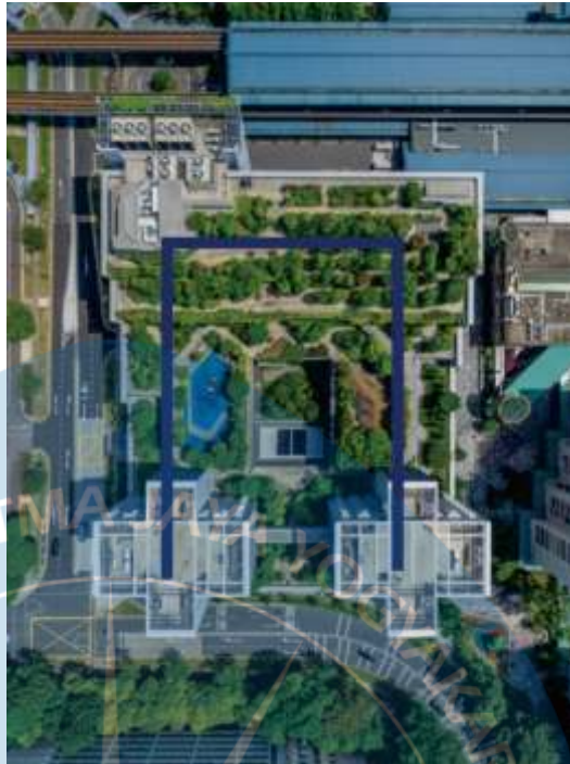
Gambar 2. 17 Bentuk Bangunan Kampung Admiralty Sumber : WOHA Architects (diubah oleh penulis)
