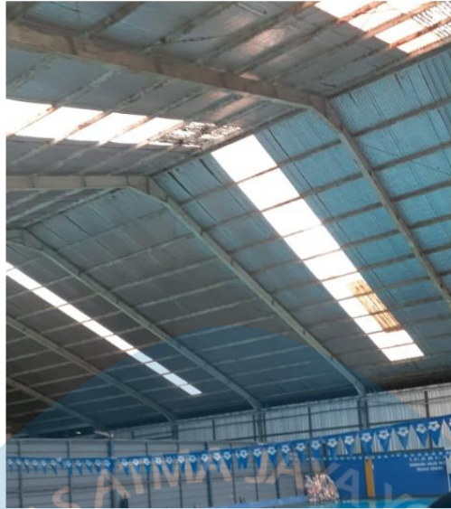
Gambar 2.28 Struktur Atap Depok Sport Center Sumber: Google Maps, 2021
