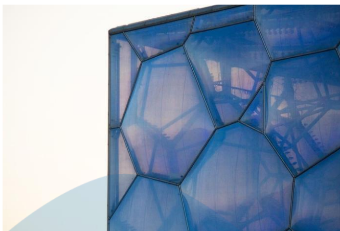
Gambar 2. 24 Membran Pneumatis Beijing National Aquatics Centre Sumber: ArchiTravel.com (Diakses pada tanggal 8 Oktober 2020)
