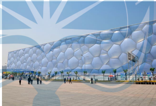
Gambar 2. 23 Beijing National Aquatics Centre Sumber: ArchiTravel.com (Diakses pada tanggal 8 Oktober 2020)
