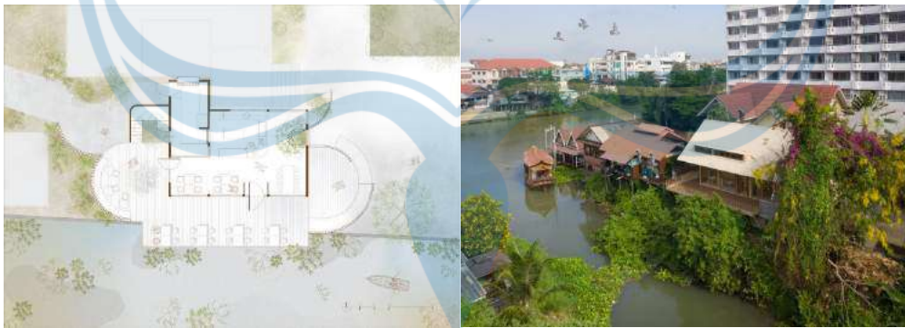
Gambar Error! No text of specified style in document.2 Bangunan Berbatasan Langsung dengan Sungai
