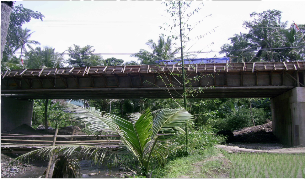
Gambar 1.3. Jembatan Kali Keji
