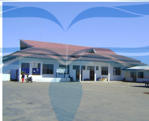
Gambar 1.2 Terminal Penumpang Pelabuhan Saumlaki
