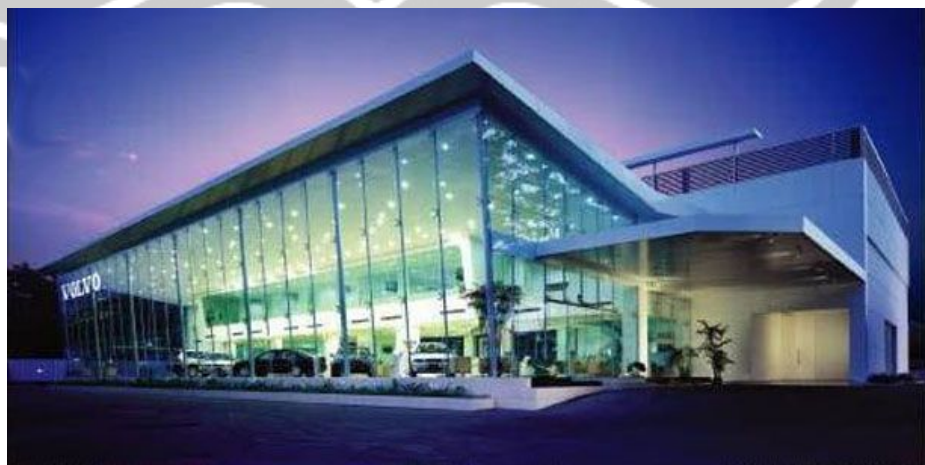
Gambar 2.11 Wujud bangunan Showroom
