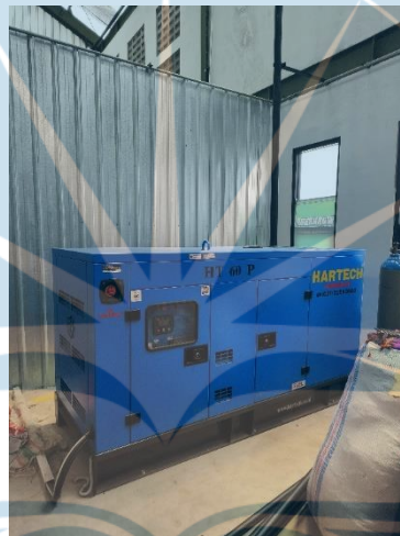
Gambar 3. 5. Kondisi Gudang Material, dan Penunjang lainnya (2)
