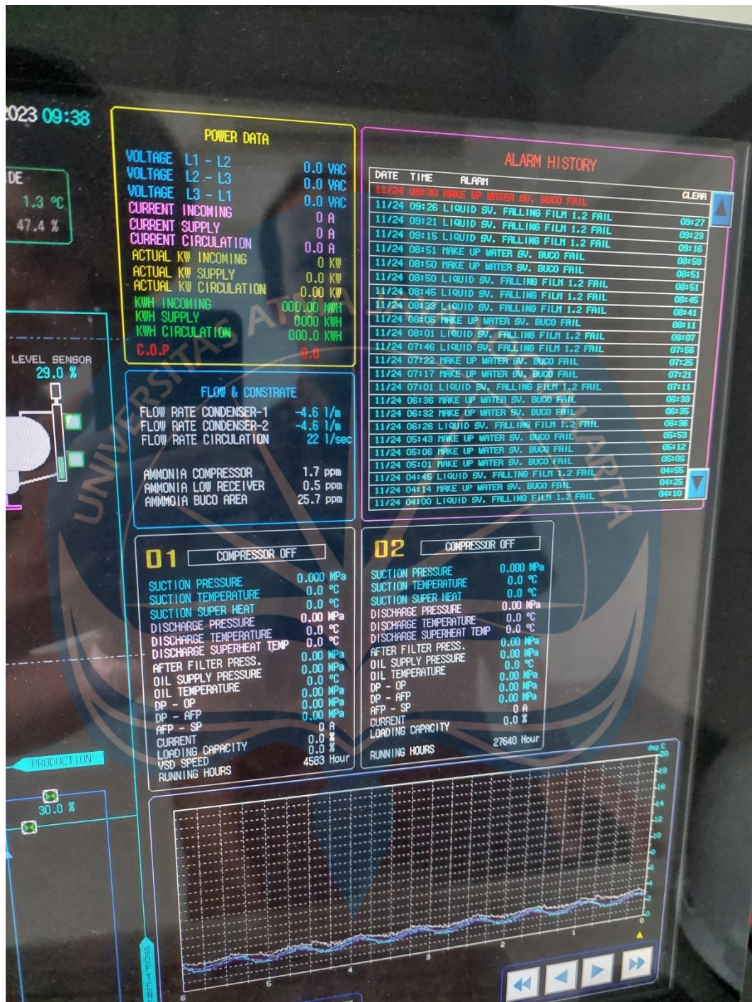
Lampiran 3 Dashboard Mesin Chiller yang Mati
