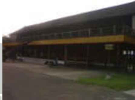
Gambar 5.9 Rumah Panjang menggunakan bentuk panggung dengan atap pelana. Orientasi atau arah hadapnya menuju sungai.
