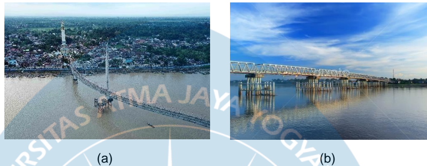
Gambar 1.3 (a) Jembatan Gentala Arasy (b) Jembatan Aurduri I
