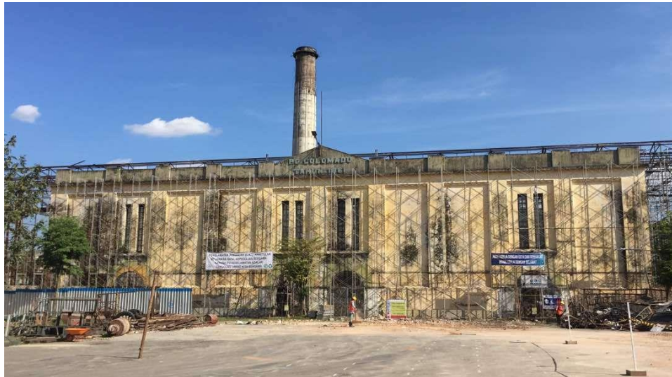
Gambar 2. 5 Bangunan Pabrik Gula De-Colomadu sebelum pelaksanaan Revitalisasi
