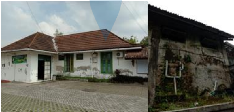
Gambar 1.3 Kondisi Ruang Luar Gedung Pastoran Somohitan
