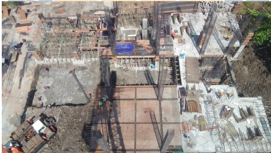
Gambar 2. 2 Tampak Atas Lokasi Proyek UPI Cibiru
